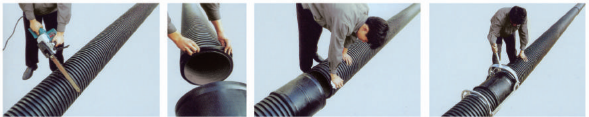
1.现场切割 2.现场套置橡胶密封圈 3.清洁连接处的脏物 4.人工、机具承插连接
