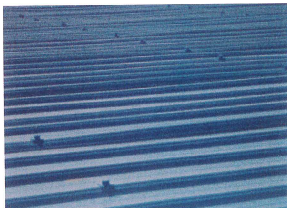
安装两年的带防水配件的PVC瓦屋面光洁如初
