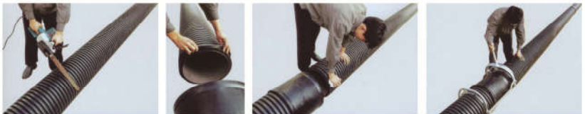
1.现场切割 2.现场套置橡胶密封圈 3.清洁连接处的脏物 4.人工、机具承插连接
